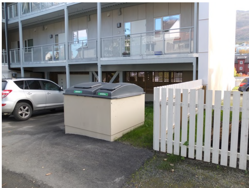
Fig. 23. Eksempel på dypoppsamlingsanlegg, renovasjon, for Frydenlundgata 31. Foto Gisle Jakhelln sept. 2016.
