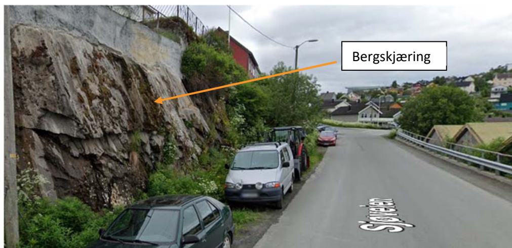
Figur 4-4: Streetview fra Sjøveien. Det er en høy bergskjæring mot sørøst [google maps]
