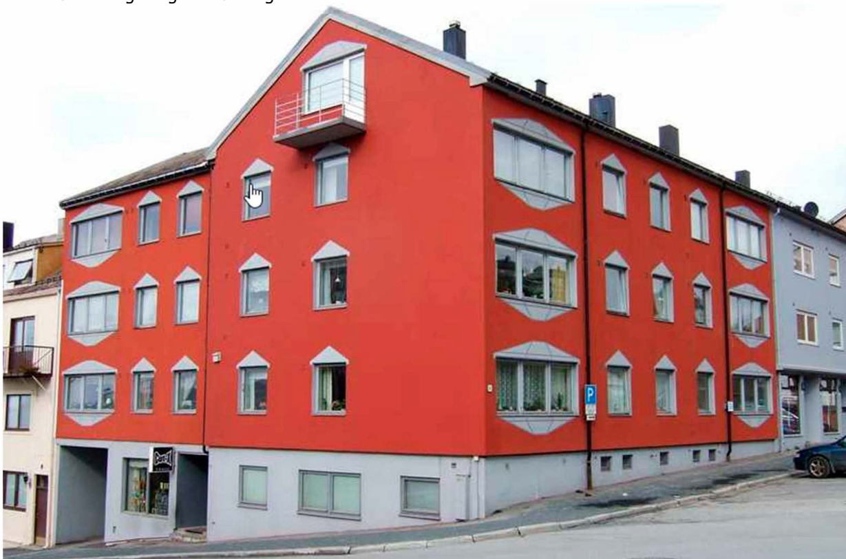
Bilde 11: Dronningens gate 19 fotografert trolig 2007 12
