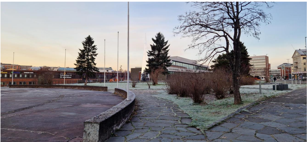
Figur 6: Parkhalltaket, retning nord. Bilde: Sweco Norge AS.
